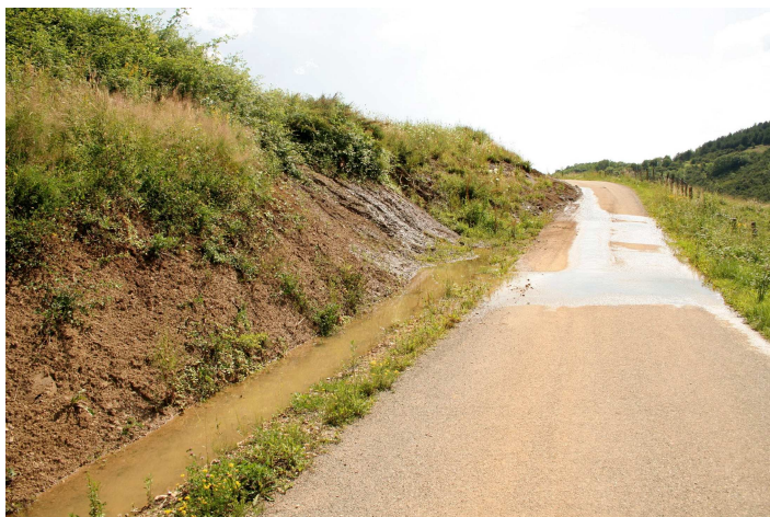
31. Certains terrains sont localement instables – ici glissement de terrain à "Fin de Vaux"
