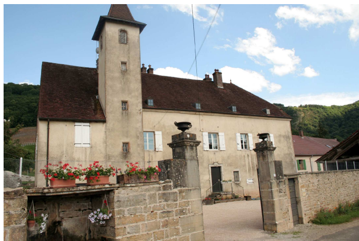
28. Le bourg - Ensemble architectural intéressant, avec sa tour carrée
