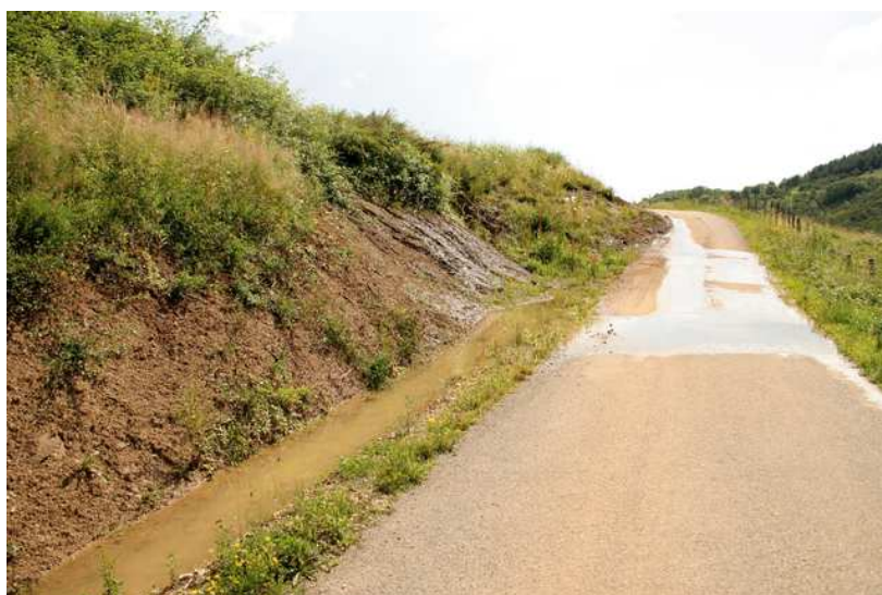
Glissement de terrain le long de la VC2
