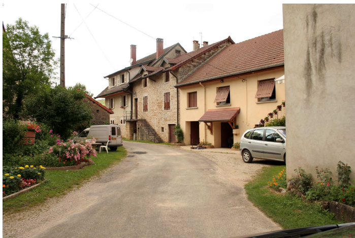
39'. Ensemble bâti ancien rénové – quartier des Marchands
