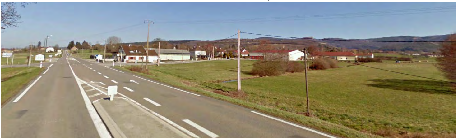
Photo 1 : Les éléments donnés à voir depuis la RD1083
