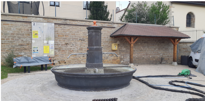
Pendant les travaux
