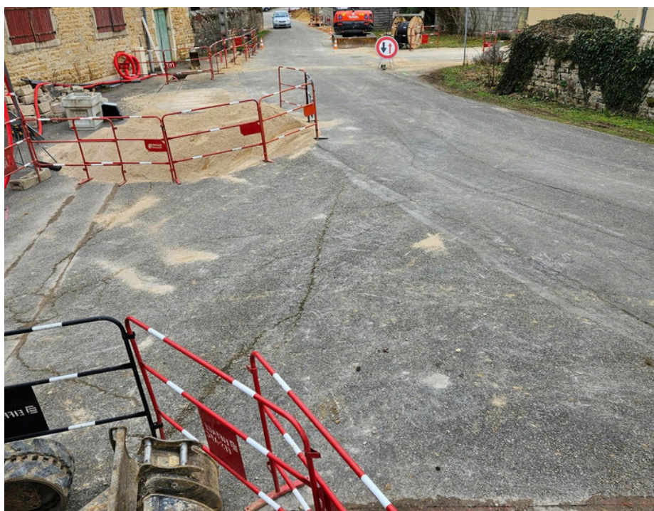
PAGE 13 | ENFOUISSEMENT DES RÉSEAUX À SAINTE-AGNÈS
